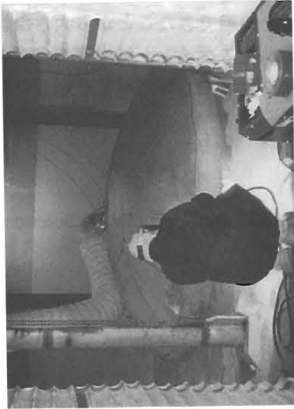
写真3 CWTRの解体撤去作業〔左〕タンクを吊り下げている。下部は既に切断撤去された。〔右〕上部ドーム部の細断。 プラズマトーチを使用。手前に壁開口部も見える。
