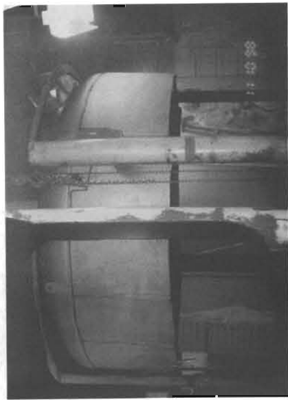
写真3 CWTRの解体撤去作業〔左〕タンクを吊り下げている。下部は既に切断撤去された。〔右〕上部ドーム部の細断。 プラズマトーチを使用。手前に壁開口部も見える。
