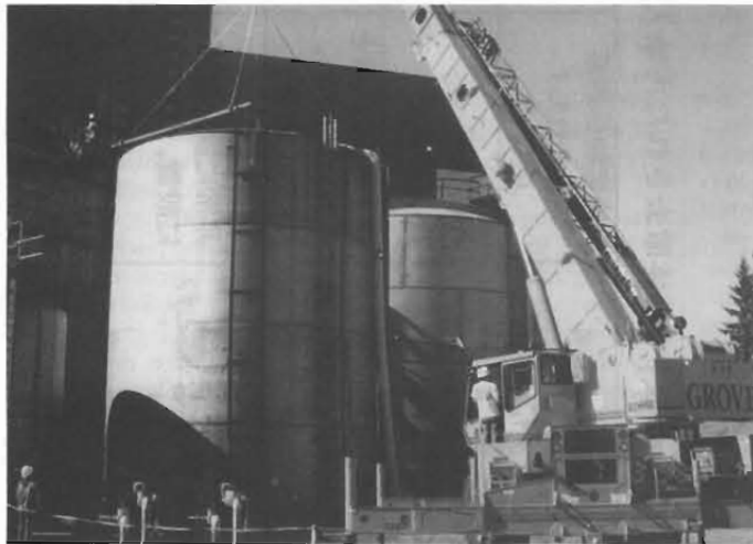
写真1 PWSTの解体撤去作業 (吊下げ用の支柱を設置している。)
